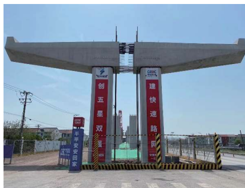
图 5 反拉法安装盖梁现场施工图
