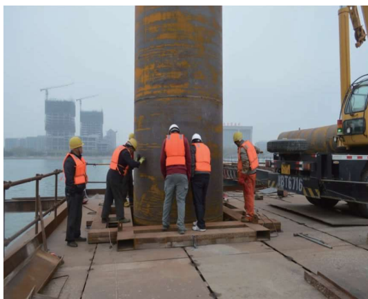
图 2 钢护筒利用导向架定位和控制垂直度
