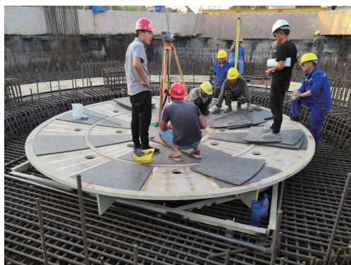
图 4 下球铰滑板安装
