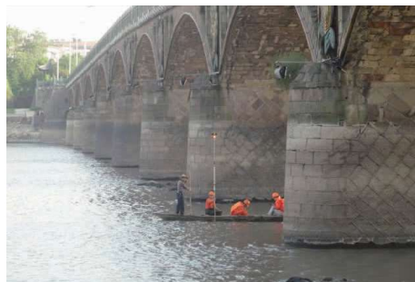
图 3 桥梁结构立面照
