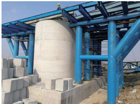
图 9 某城际铁路 19# 墩现场施工情况 弹性波 CT 分别于墩身距地面 0.3 m 高度及 0.8 m 高度布设水平测试剖面,检波器间距为 0.5 m,炮点间距为 0.5 m。单个剖面测试数据 2048 个,射线正交性和射线密度满足要求。 由图 10 可知:0.8 m 高度剖面平均波速为 3 580 m/s,0.3 m 高度剖面平均波速为 3 593 m/s,墩身波速总体呈现两侧大中间小特征,但并无局部异常,表明桥
