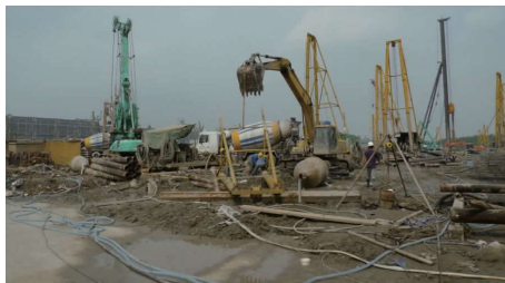
图1 基坑现场情况之实景
