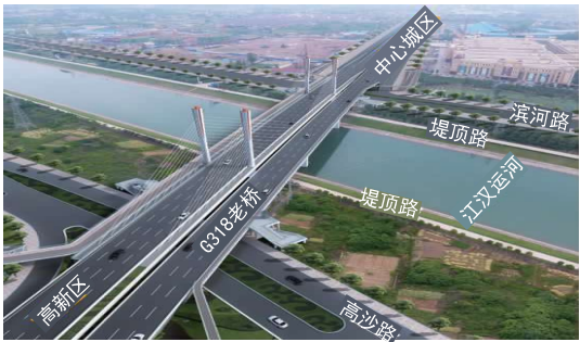
图 9 最终选取双塔斜拉桥桥型方案
