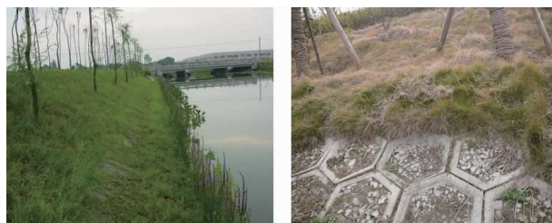
图2 生态混凝土护坡
