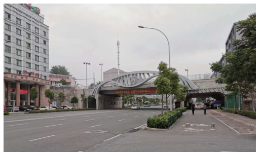
图9 新建金象立交桥实景
