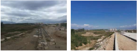
图 8 处理完工后现场
