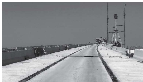
图 10 引桥小箱梁架设安装完成
