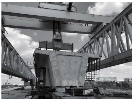
图5 重心偏移的边梁吊装(单位:mm)
