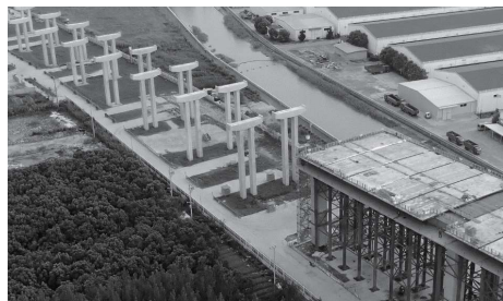
图6 主桥边跨先于引桥安装完成
