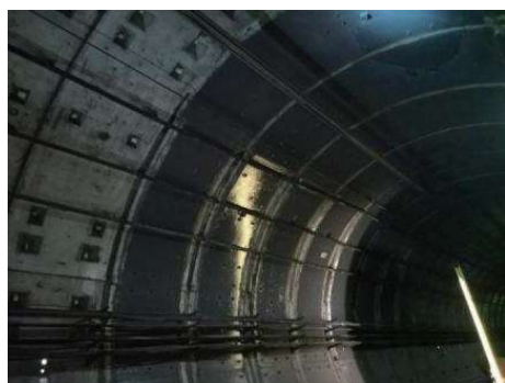
图2 7号线区间隧道钢套环加固
