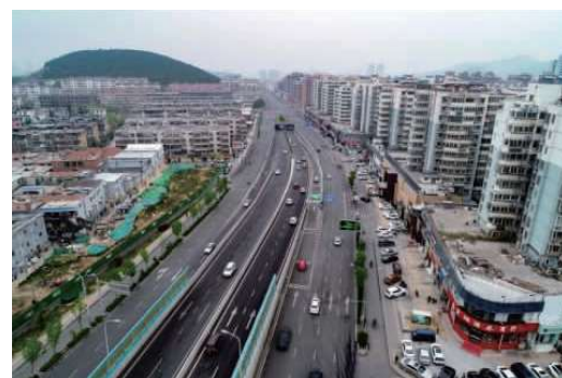
图 14 地下道路南洞口节点建成后实景
