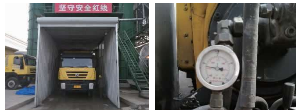
图6 浇注式沥青混合料装料及压力监测
