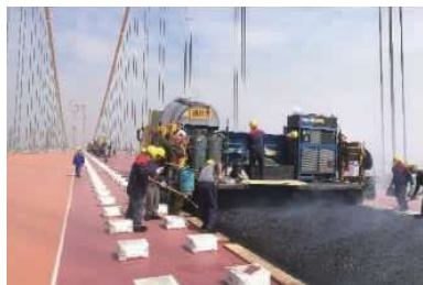
图7 浇注式沥青混合料摊铺
