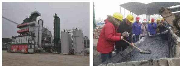
图5 浇注式沥青混合料生产(试拌)
