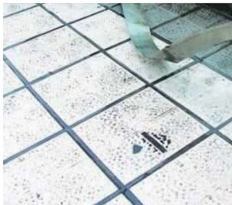
图 4 防滑地砖铺装
