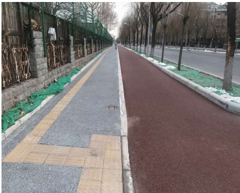
图 3 道路改造完成后现场照片
