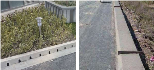
(a)路缘石开孔设置 (b)路缘石断开设置
