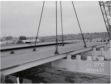
图11 桥面系施工现场
