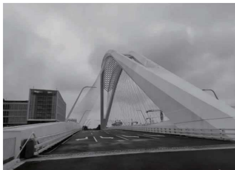
图 18 桥梁实景图片
