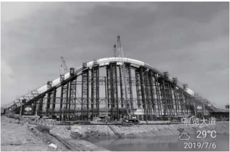
图6 拱肋施工现场
