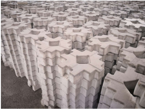
图9 预制完成的新型连锁块之实物
