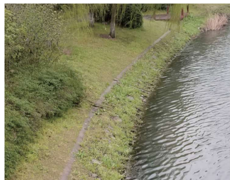
图 1 生态混凝土护坡(嘉定区赵泾)之实景
