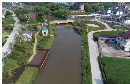
图11 工程完工后航拍图
