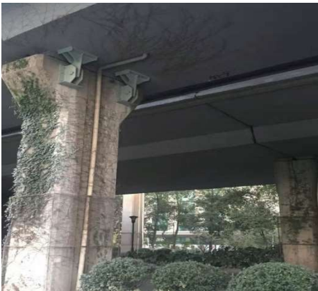
图2 增设抗拉拔装置改造后照片
