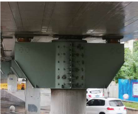
图 6 增设双支座改造后照片
