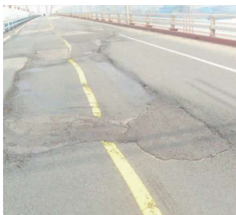
图 1 典型剪切推移病害图
