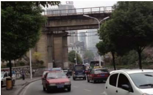
图 5 现状西陵二路下穿鸦宜铁路照片
