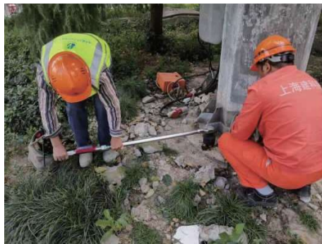
图 6 采用扭力扳手检测螺帽扭矩
