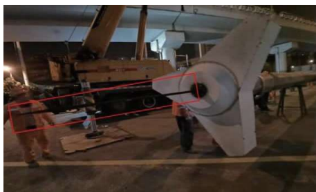
图 5 杆顶应有效设置避雷针
