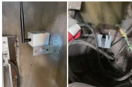
图8 在杆体表面焊接安装倾斜监测传感器
