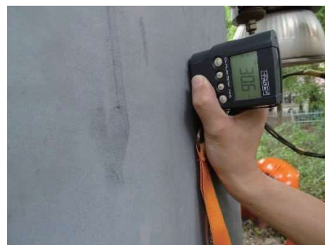
图4 灯杆表面涂层厚度检测
