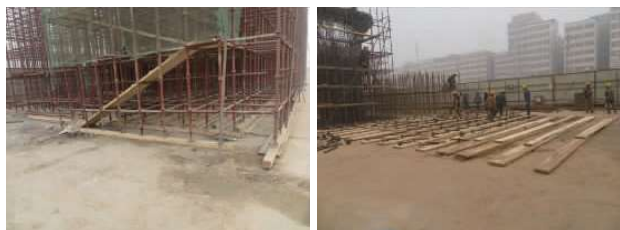
图3 在宽木板上垫方木再搭设支架
