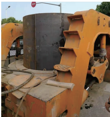
图 1 摇管机安装、安放钢筒
