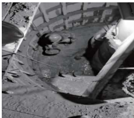
图 7 封底混凝土浇筑
