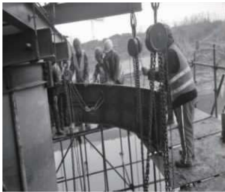
图 6 钢套箱拼装
