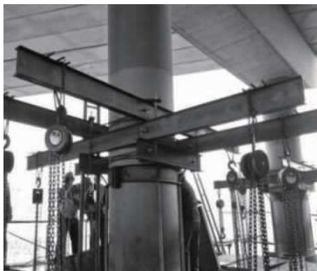
图 5 反力架安装
