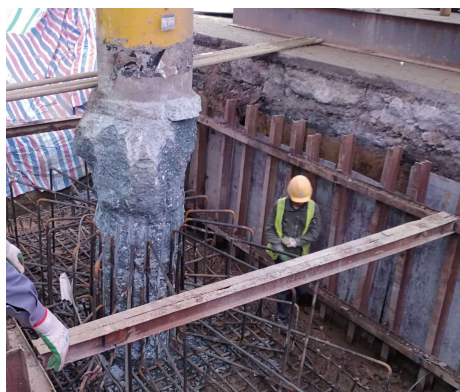
图 6 扩大基础钢筋施工图
