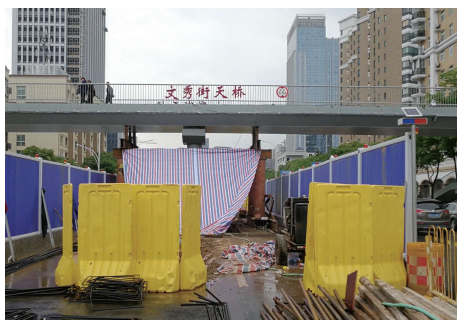
图 5 现场临时支架图
