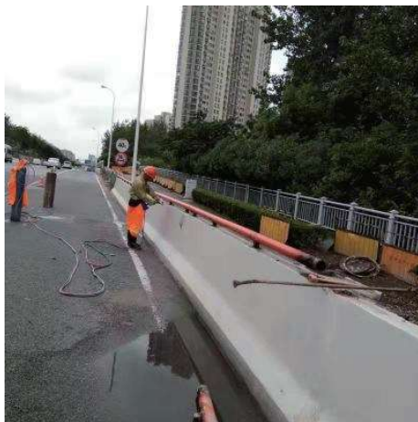
图 1 原顶管拆除
