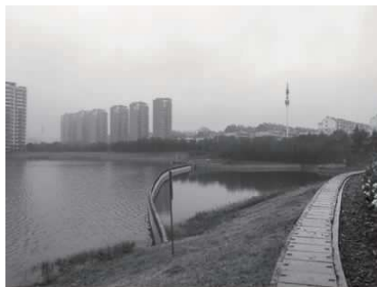
图 8 黑臭水体治理工程实施后项目现场图
