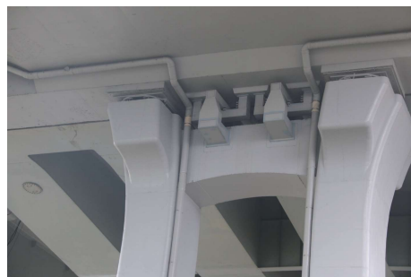
图7 海秀快速路三向限位装置(边墩)之实景
