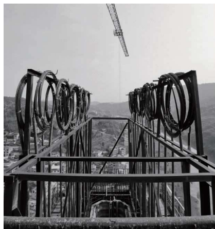
图5 竖向预应力钢束安装现场照片
