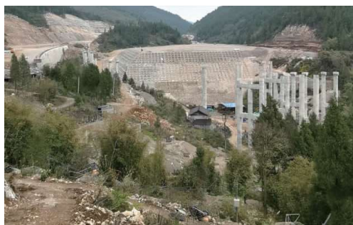
图2 互通桥现场地形地貌
