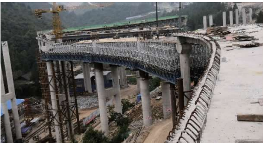
图 5 互通区桥梁支架施工
