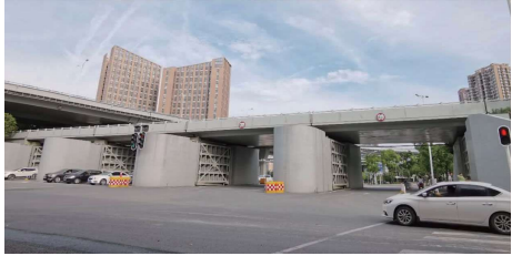
图8 姑嫂树交通闸建成后实景
