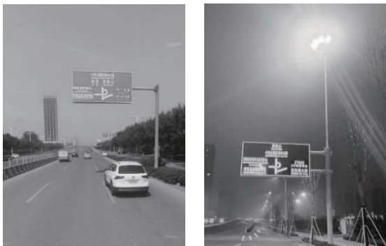
图 9 半透式面板显示主动发光指路标志
