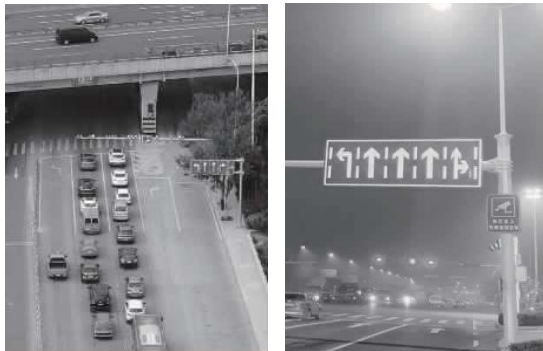
图 8 半透式面板显示主动发光分车道标志
