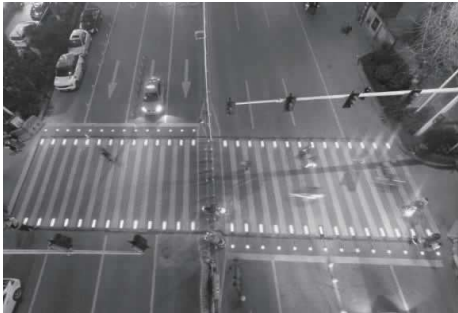
图 7 彩色灯带发光斑马线(湖南长沙)
