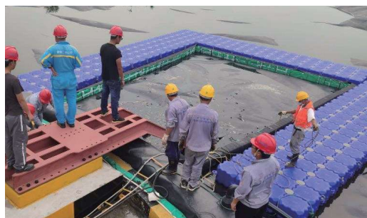
图3 膜下取泥开口处图
