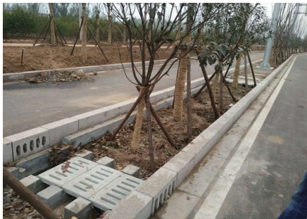
图 13 道路豁口与预沉池实物图(单位:m)
