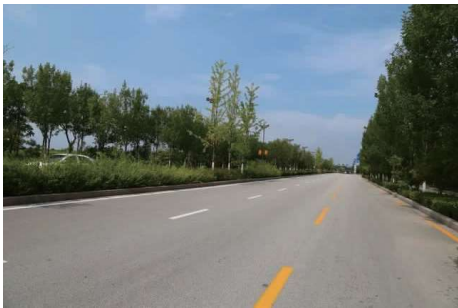
图 16 道路竣工实景
