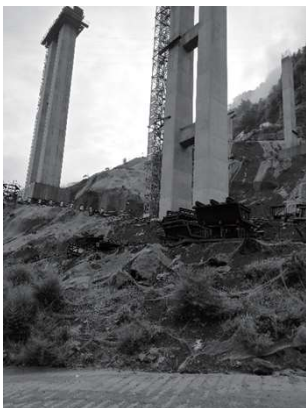
图 1 河流两岸的桥梁桩基 分为人为因素和自然因素两大类。
