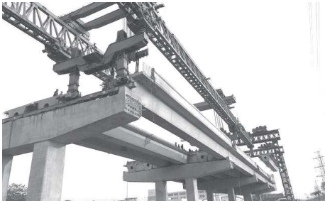
图4 小箱梁架设施工
