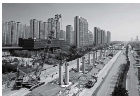
图11 履带吊机施工实例
