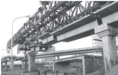
图5 节段预制拼装施工
