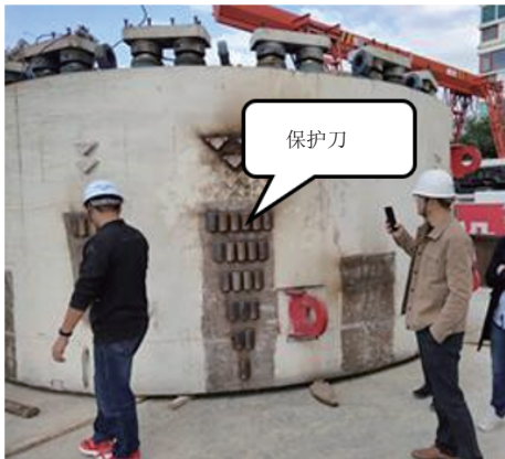
图5 安装好的外置注浆盒保护刀
