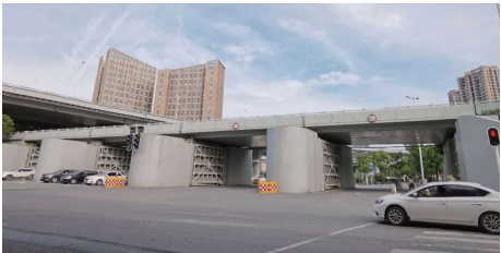
图8 姑嫂树交通闸建成后实景
