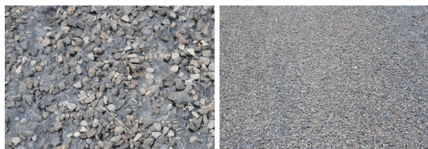
图5 纤维封层养护施工现场图
