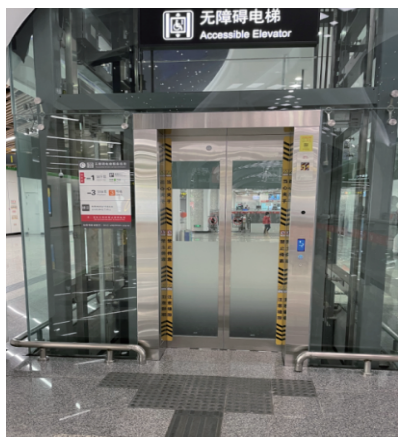
图1 盲道与无障碍电梯连通方式
