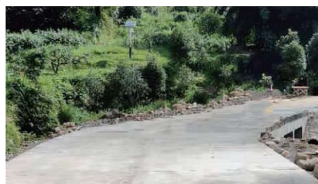
图9 箱涵顶板兼做路面层
