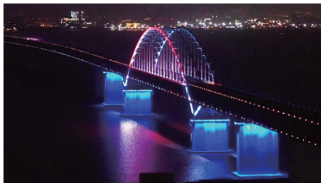
图3 天生港专用航道桥夜景照明实景图
