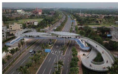
图11 海口市龙昆南路“飞鱼”人行桥实景照片(2021年4月)
