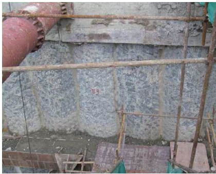
图4 钻孔咬合桩工法
