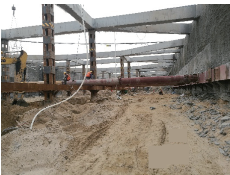
图10 河道内基坑支护剖面图
