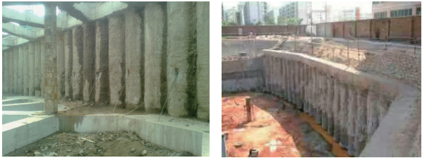
图 2 钻孔灌注桩支护
