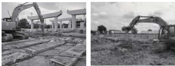
(a)昆阳路越江及配套道路工程 (b)S3公路新建工程
