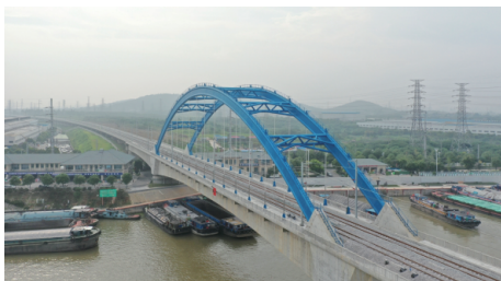
图 1 跨越苏南京杭运河(76+136+76)m 连续梁拱成桥照片
