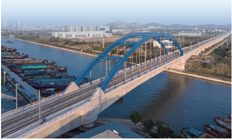
图 6 跨越京杭运河水上服务区连续梁拱实景
