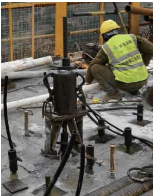
图 2 竖向预应力钢筋张拉施工示意图
