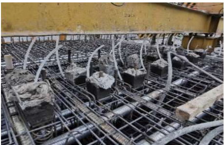
图 4 竖向预应力钢筋压浆接通照片
