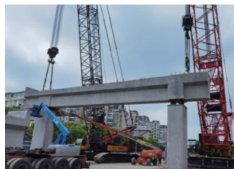
图9 预制盖梁现场拼装
