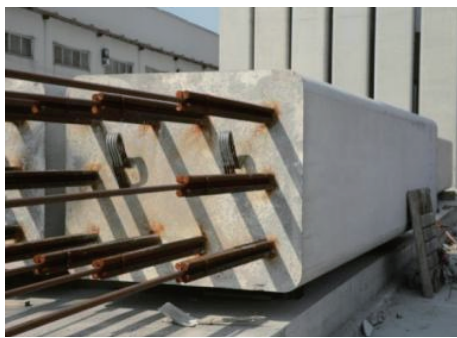
图6 浇筑后集束钢筋相对位置
