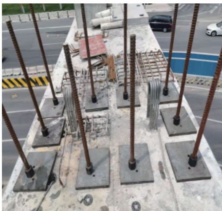
图 12 张拉后锚固
