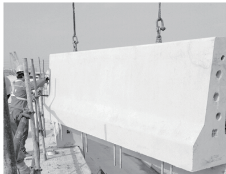
图 13 预制拼装护栏
