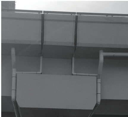
图1 市政倒T盖梁处防撞护栏
