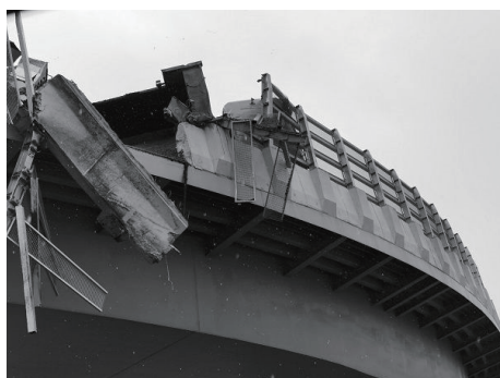
图 11 护栏与桥面板连接不足
